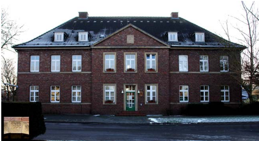
Das Dienstgebäude an der Neuenkirchener Straße 1938 bis 1979
