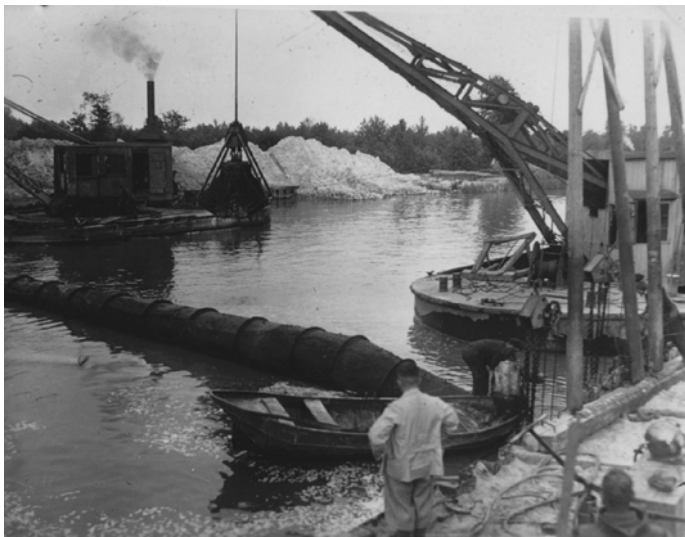
Ausbauarbeiten am Kanal um 1936
