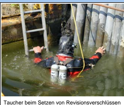
Taucher beim Setzen von Revisionsverschlüssen
