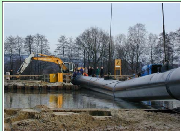
Einheben der Rohre des Schmiemann-Dükers
