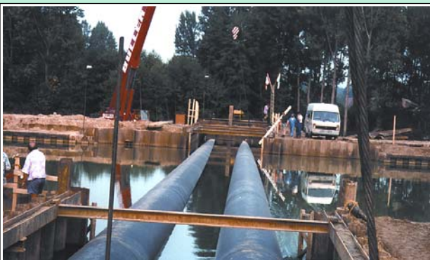
Positionierung der Dükerrohre vor dem Absenken unter die Kanalsohle
