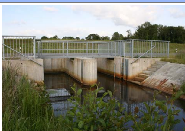
Fertiges Auslaufbauwerk des Schmiemann-Dükers
