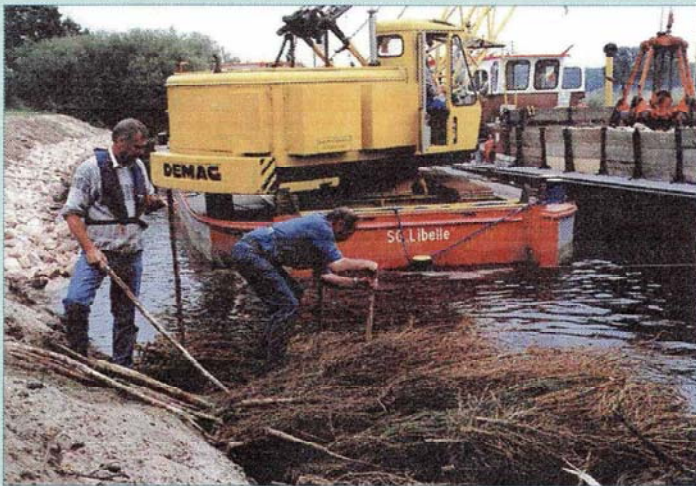
Uferinstandsetzung bis MW mit Weidenspreutlage
