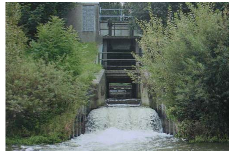
Überleitungsbauwerk bei Hamm zur Anreicherung der Lippe in Trockenzeiten
