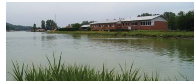
rechts: Das Gebäude der Leitzentrale
